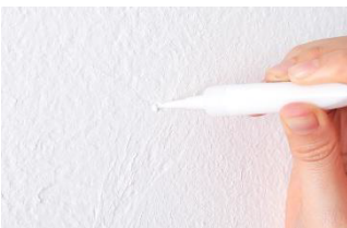
1：穴に補修パテを埋める。
